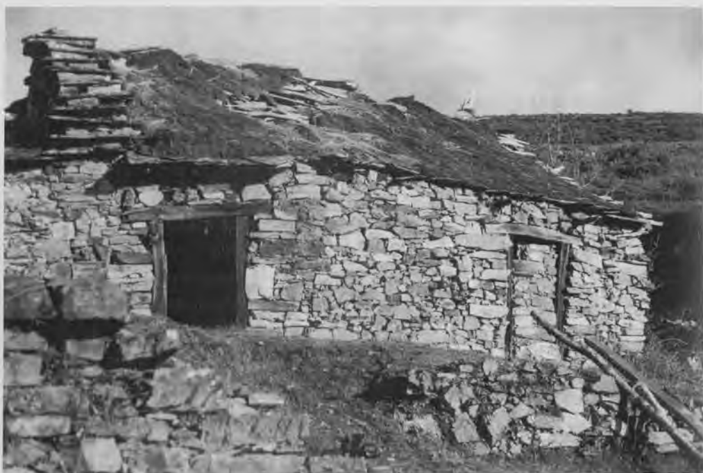
Casa de teito de Vilarbón, cun penal escaleirado. (Foto 19).
