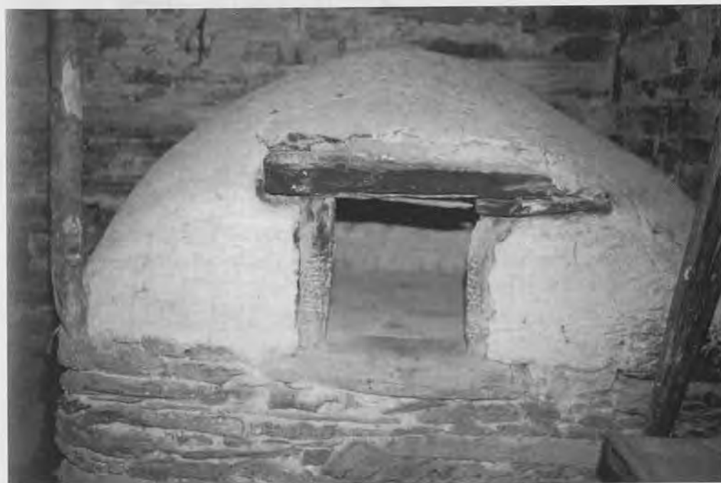
Forno de barro-palla (Vilarbón). (Foto 46).
