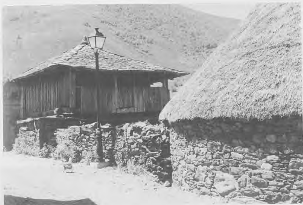
Hórreo ("paneira") de Balouta con corredores, e asentado sobre muros. (Foto 34).
