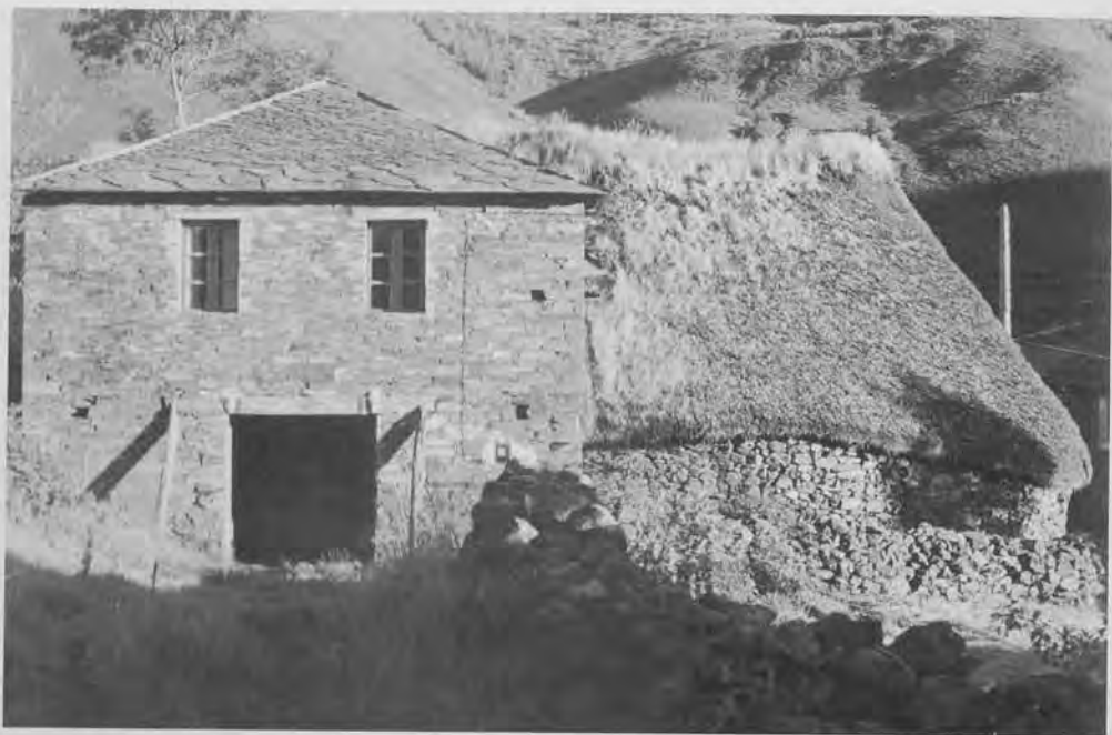
Palloza con cuarto ou cileiro unido a ela (Balouta). O cuarto, con porta para o carro e dúas ventás grandes, é relativamente moderno. (Foto 20).
