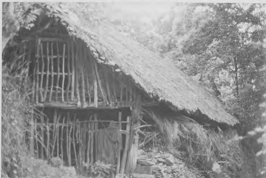
Palleiro –portal aberto, sen muros arredor, Lumeiras. (Foto 42).
