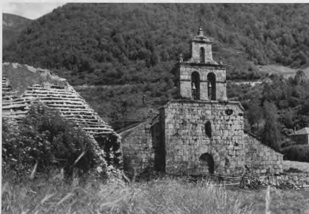
Palloza en ruínas de par da igrexa de Suárbol (1985). Actualmente xa non queda máis que parte dos muros. (Foto 7).
