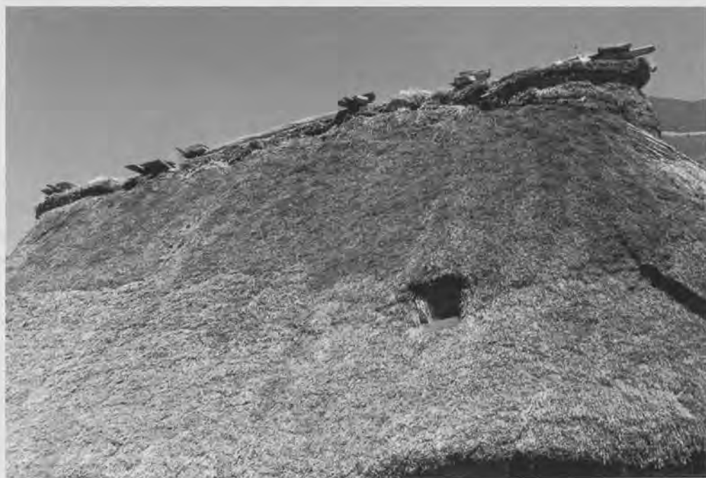
As pallozas non teñen chiminea, algunhas posúen un ventaun para saír o fume e entrar a luz, como esta de Balouta. (Foto 12).
