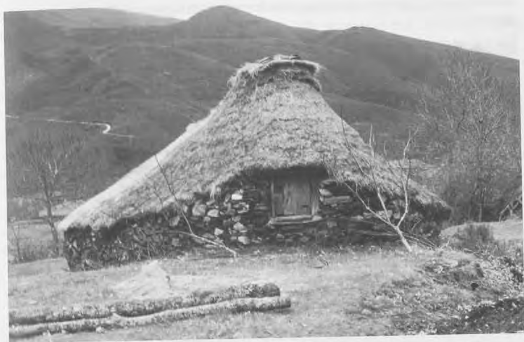
Construcción con cuberta de colmo de Sorbeira, de planta oval. Exemplo de traballo con teitos de palla no que eran expertos os ancareses. (Foto 13).
