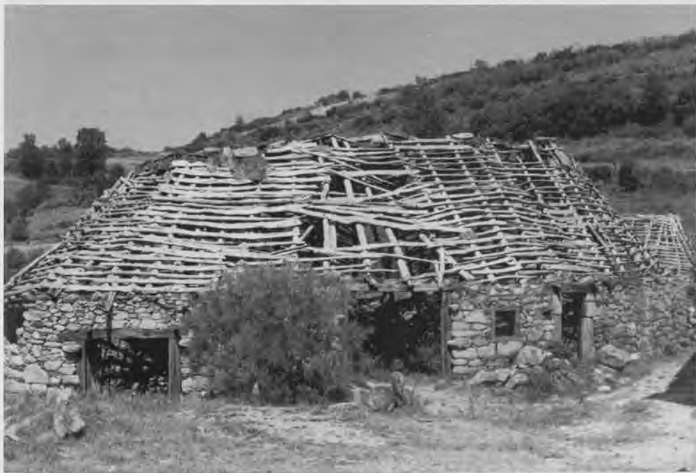
En 1985 da palloza grande de Suárbol xa só quedaban o armante e os muros ruinosos. Actualmente non é máis que unha morea de pedras. (Foto 15).
