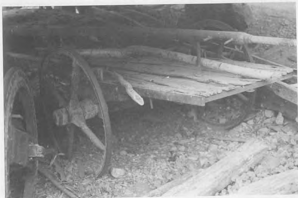
Carro coas rodas e a pértega de ferro. O único de madeira é o eixe e o estrau (Balouta). (Foto 58).
