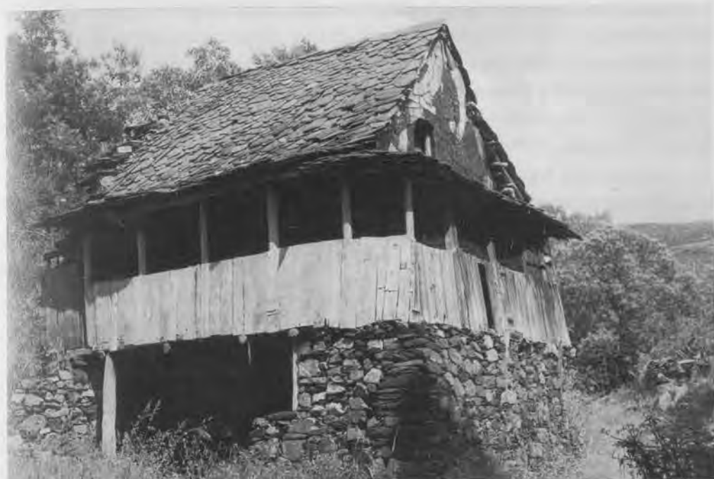
Este cileiro de Vilasumil conta cun amplo corredor en dous lados. (Foto 22).
