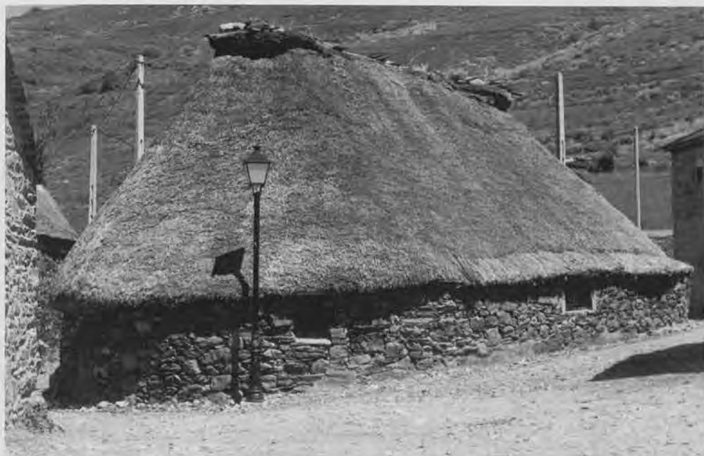
As pallozas de Balouta son de planta elíptica ou oval, a non ser que sufrisen arranxos ou engadidos posteriores. Neste caso os ocos das ventás son recentes. (Foto 13).
