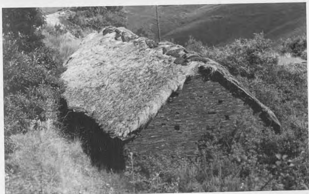
Outro exemplo de cuberta vexetal, neste caso nunha construción rectangular. Paradela, nas proximidades do val de Fornela. (Foto 14).
