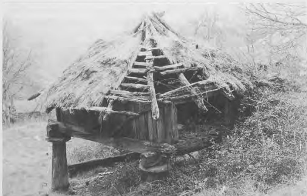
Hórreo de Vilarbón: é o único do luguer que conserva a cuberta de colmo. Os pés son de madeira. En todo o concello só hai así dous máis (un en Suárbol e outro en Balouta). (Foto 30).
