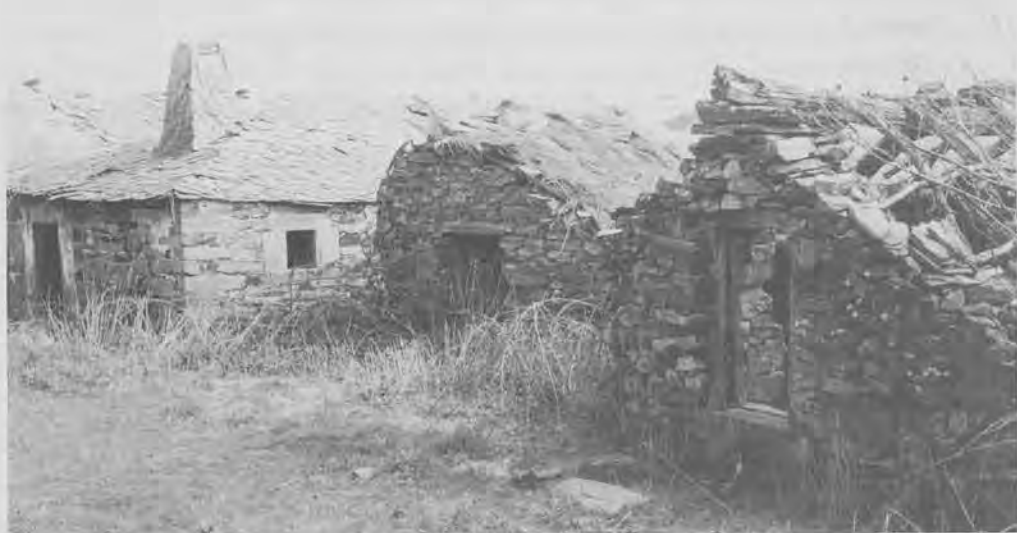
Dous palleiros de Vilarbón con boqueiro para meter a palla pola parte de arriba, aproveitando o desnivel do terreo. Quizais foron antano vivendas. (Foto 43).
