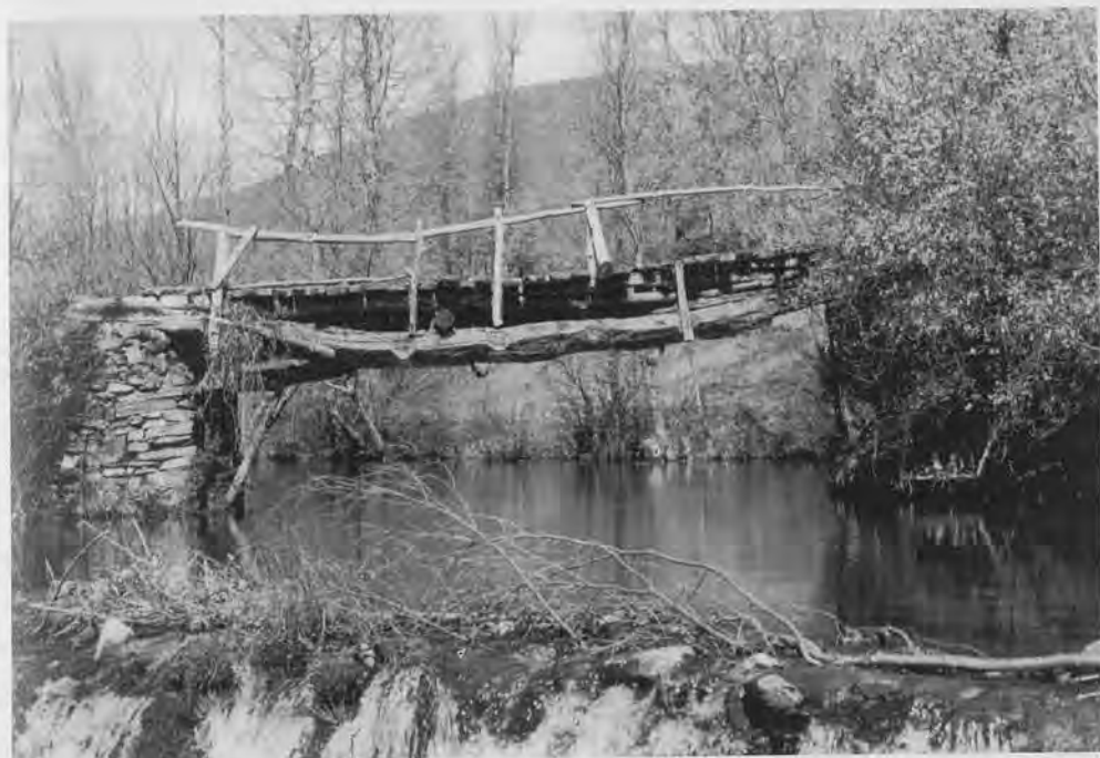
Ata non hai moitos anos tódalas pontes eran de madeira, como a Ponte Vella de Sorbeira, que actualmente é a máis grande de cantas quedan no val. (Foto 2).
