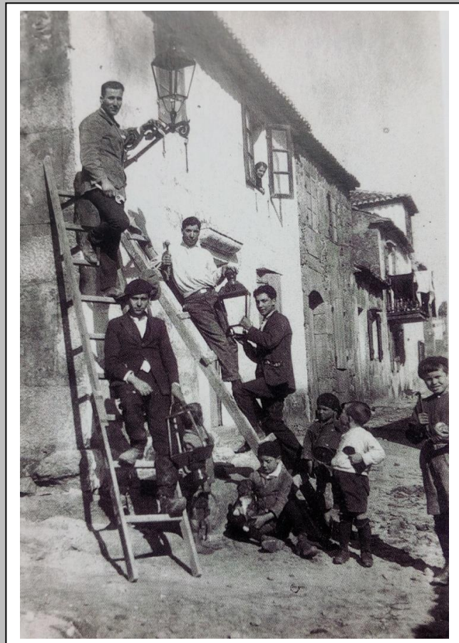
Instalación de farois na praza do Cabo da Vila (R. Caamaño, 1926)
