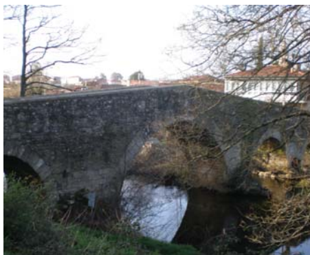
Ponte de Furelos
