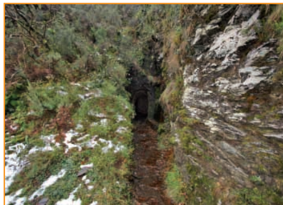
Detalle da entrada ao túnel
