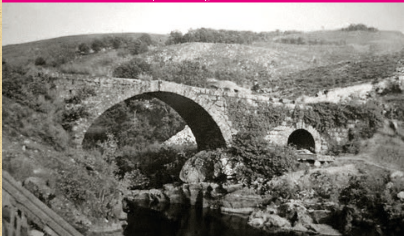
Ponte Pedriña, baixo as augas do encoro das Conchas
